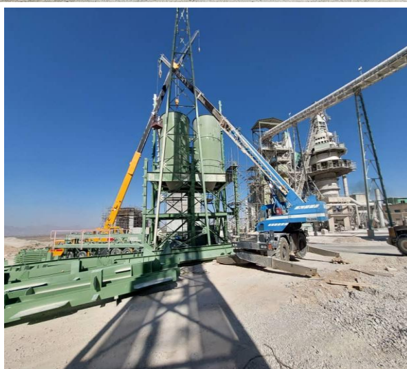
ساخت و نصب بین ورک لدر، گالری و ترستل های فولاد آهک مبارکه اصفهان
