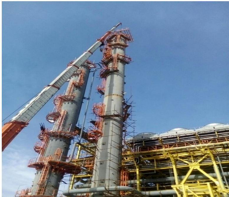
ساخت و نصب اکسترنال واحداالفین پتروشیمی ایلام
