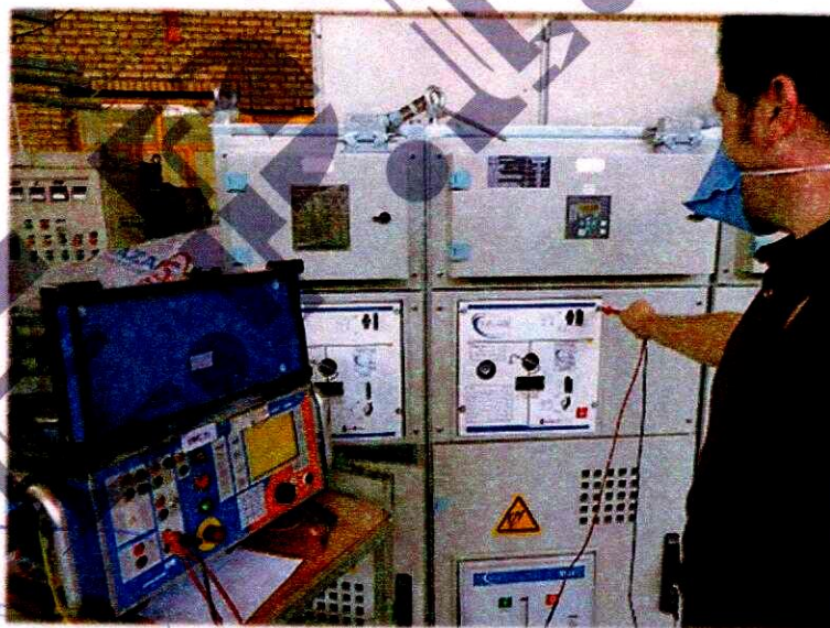
تصویر ۴: آزمون اندازه گیری مقاومت مدار اصلی
