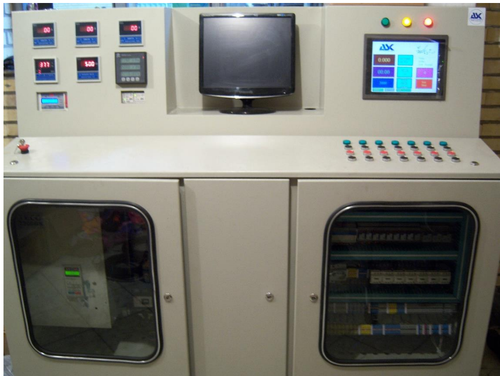
نمایی از اتاق کنترل آزمایشگاه هیدرولیک و مکانیک
